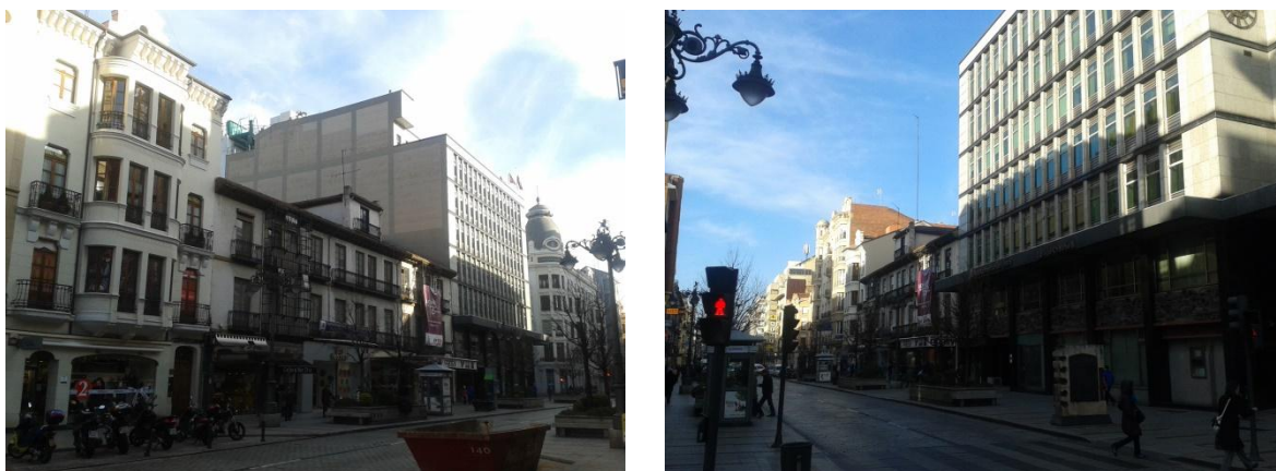
Figura 2. Vistas de las edificaciones colindantes en la avenida de Ordoño II
