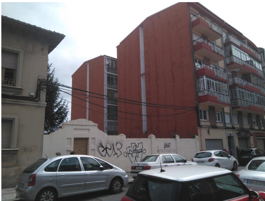
Medianera derecha (SE) vista desde Calle Daoiz y Velarde
