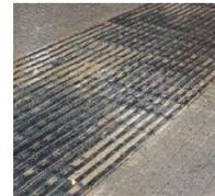
**Gráfica 42.** Ejemplo de franja de detección transversal (acanaladura) y horizontal (abotonadura) en paradas de autobús
